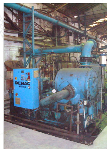
Diese Wittig WPSO Pumpen wurden ersetzt
